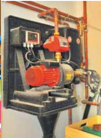
Détail de l'installation de récupération des eaux pluviales.
