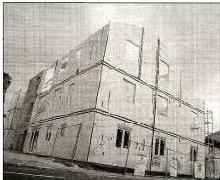
La structure de cet immeuble est en bois massif, et non en béton / Photo Alan Seveyrat
