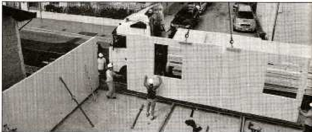
Le contenu d'un camion se monte en une journée, ce qui raccourcit les délais de construction / Photo Alain Szwycrat
