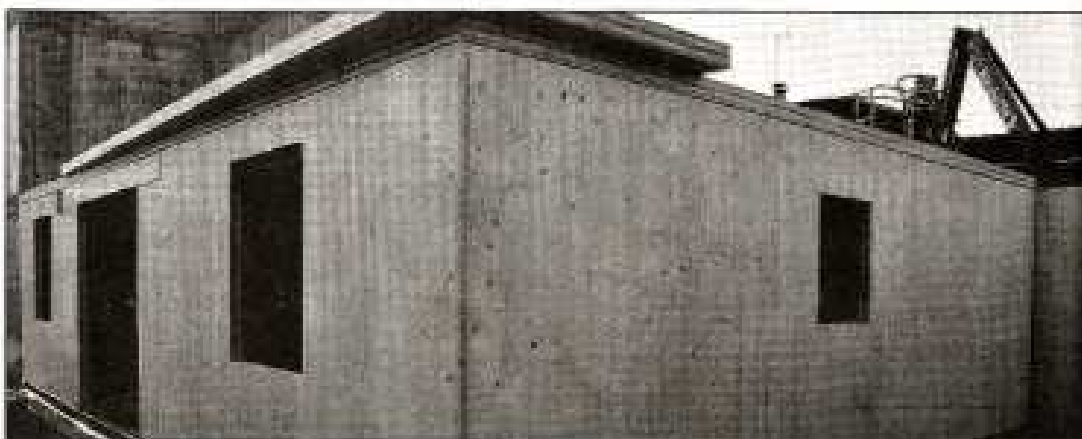
La partie Est du premier étage a été montée en une journée / Photo Alain Szwycrat
